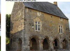
MAISON DU PORCHE
